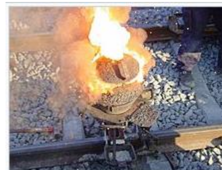
Použití termitu ke svařování kolejnic.
