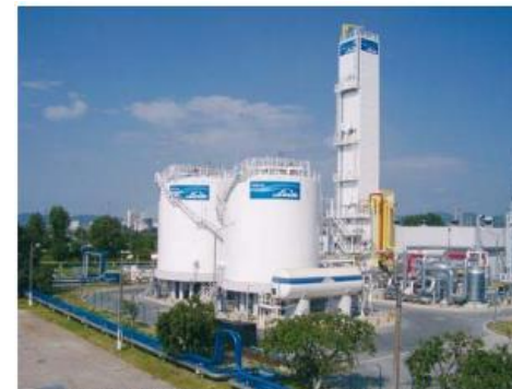
Obr.2.1 Zásobníky kapalného kyslíku a Lindeho kolona
