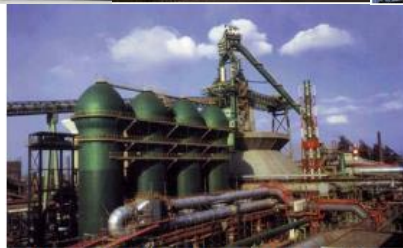
Obr. 8.1. Vysoká pec v pozadí, zprava k ní vede výtah na kusové suroviny, vepředu 4 cowpery pro
