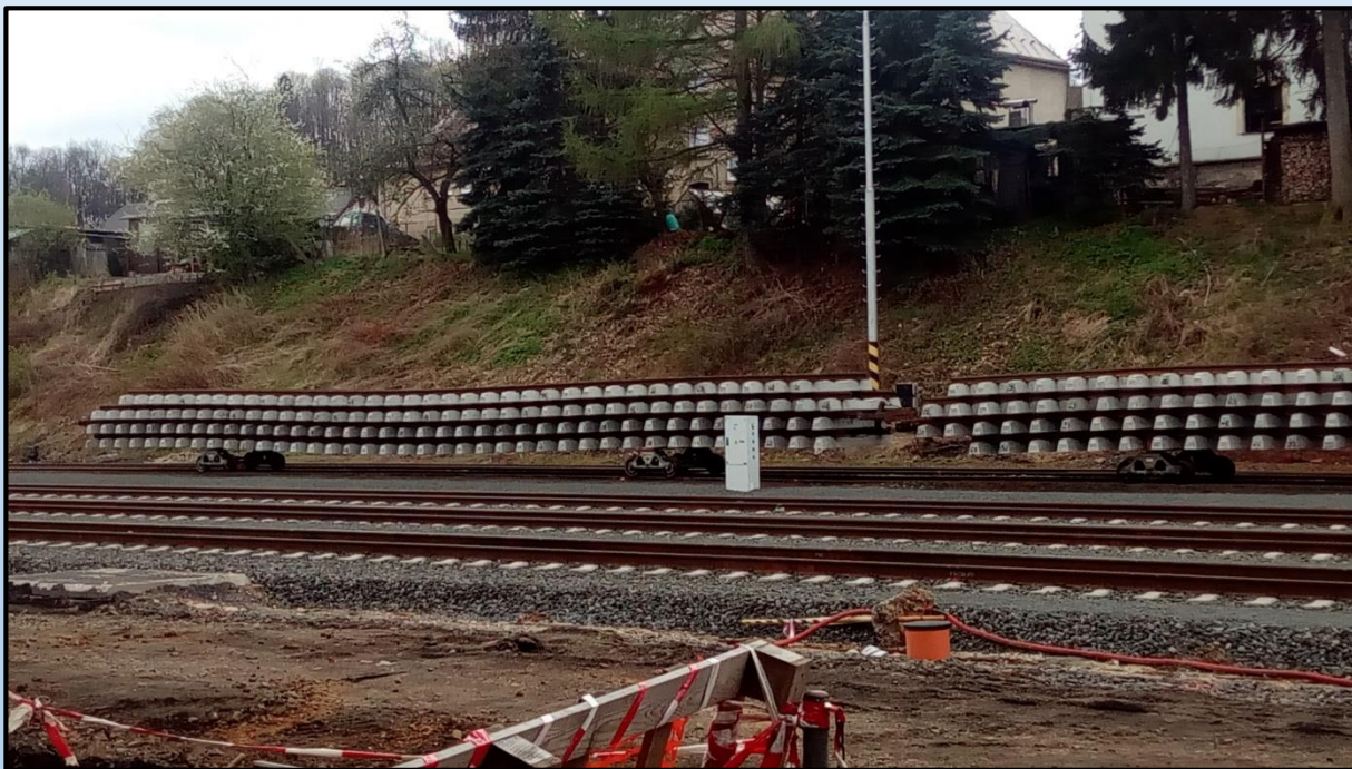
a) Kolejnice jsou v polovině „vagonu“ prohnuty dolů
