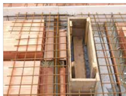
výměna u prostupu stropem pomocí vloženého úhelníku 75/50/6
