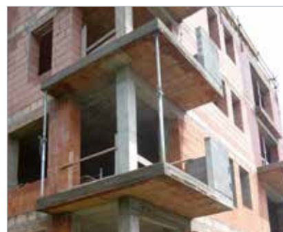
rohový balkón s přidanou výztuží
