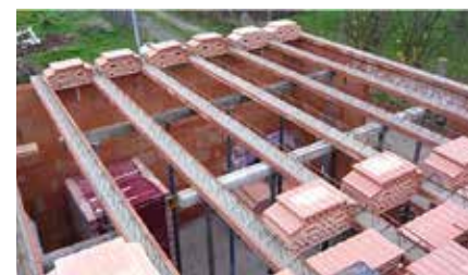
Obr. 3 Kladení vložek na předem podepřené trámy
