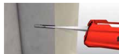
Aplikace chemické malty pomocí vytlačovací pistole se směšovacím nástavcem
