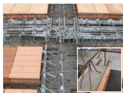
uložení trámečků do železobetonového průvlaku
