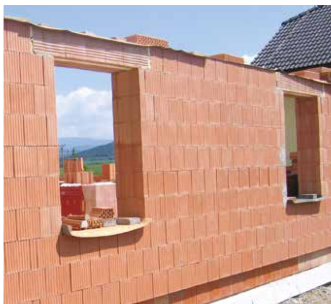
Příklady použití překlád Porothersm KP 7 u broušených cihel Porothersm T Profi plněných minerální vatou
