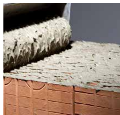
nanášení válcem na žebra cihel
