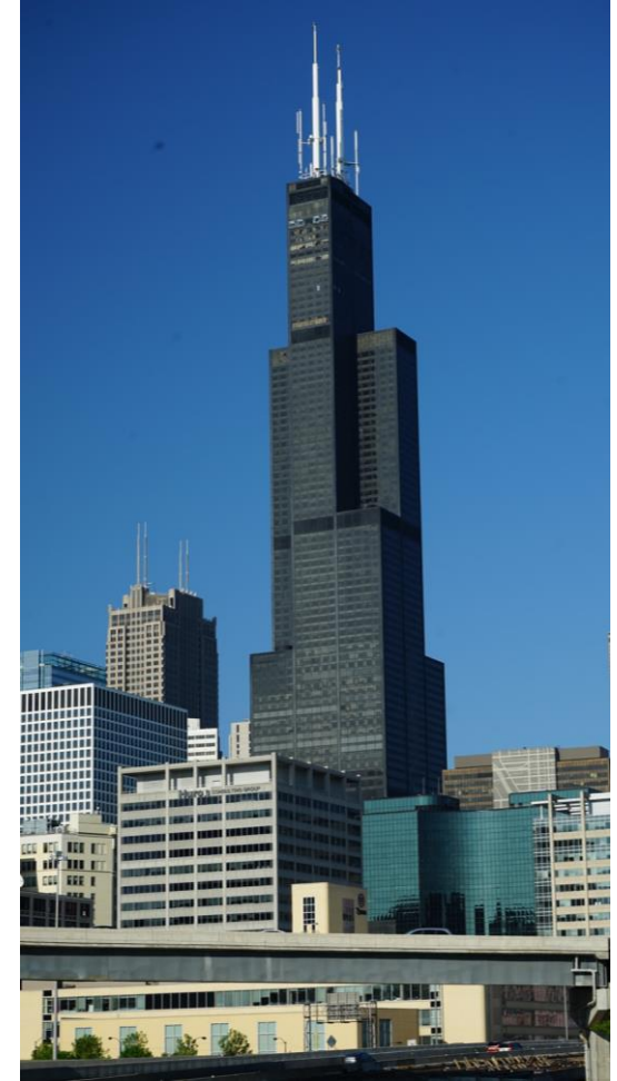
Sears Tower (Chicago) – příklad systému svazku tubusů
