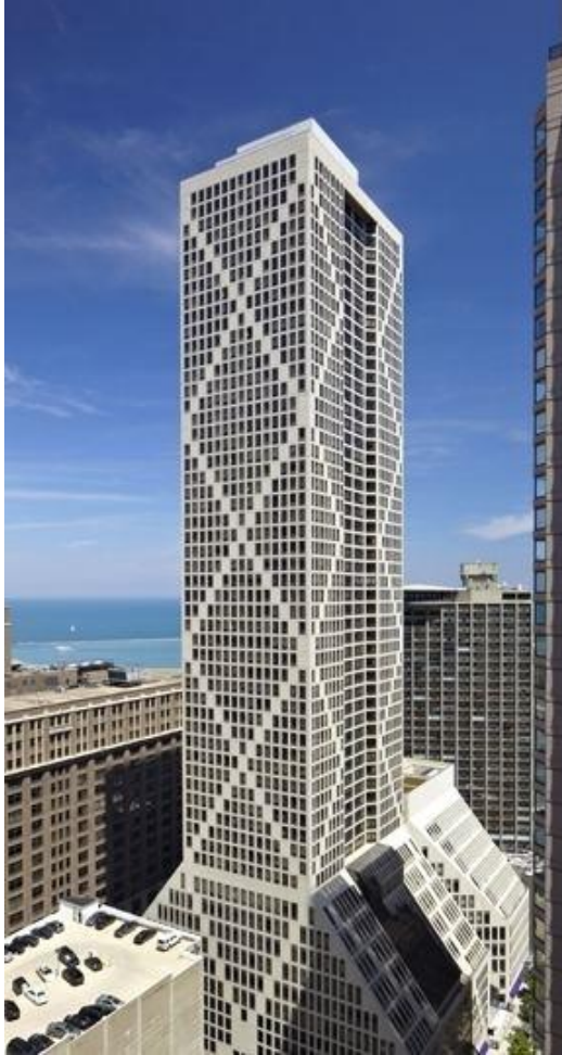
Centrum Onterie (Chicago) – příklad příhradového tubusového systému
