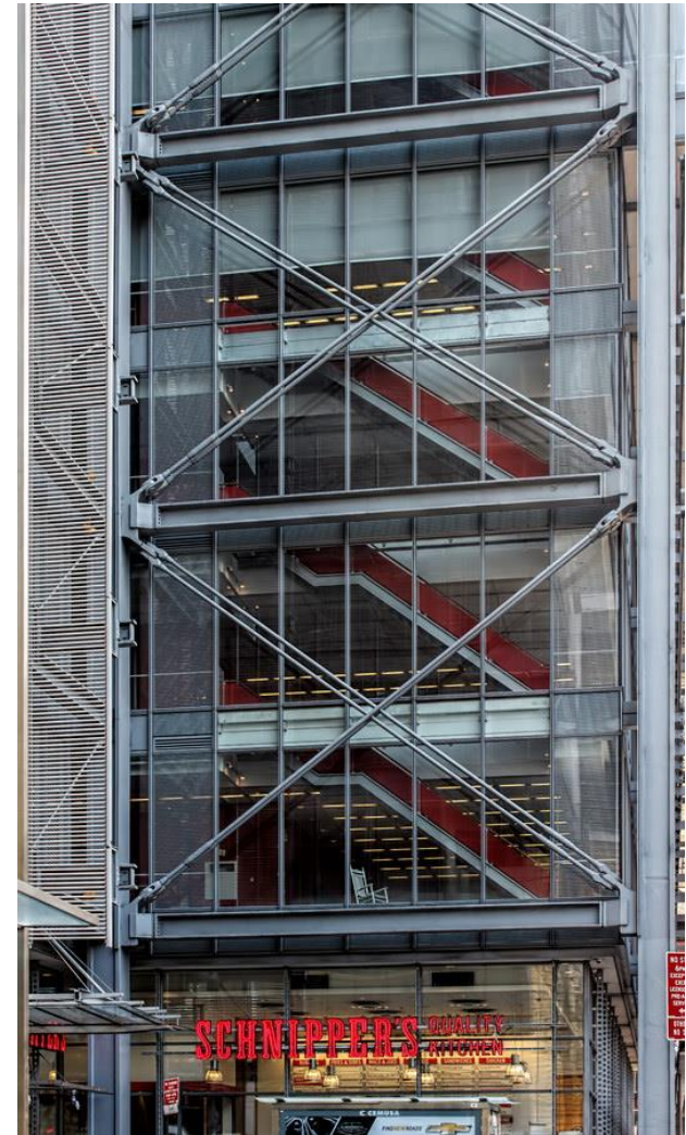
New York Times Building (NY) – příklad systému s příhradovým ztužením
