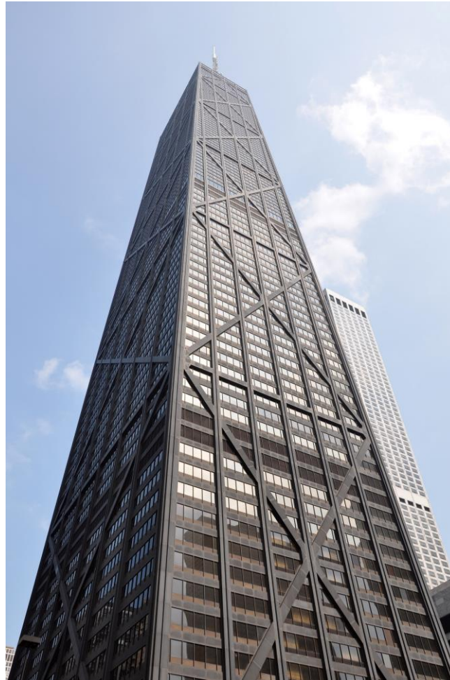
Hancock Centre (Chicago) – příklad příhradového tubusového systému
