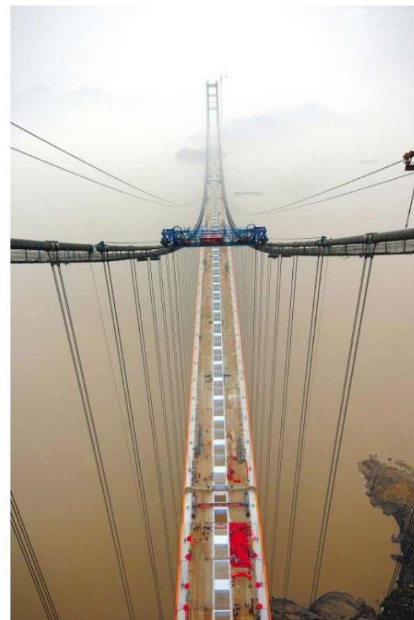
Obr.: Ocelový visutý most (Xihoumen Bridge v Číně - spojuje ostrovy Jintang a Cezi jižně od Šanghaje, otevřen 2009, rozpětí: 578+1650+475 [m], pylony: žel. bet., výšky 211 m, hlavní kabel \varnothing 855 mm)
