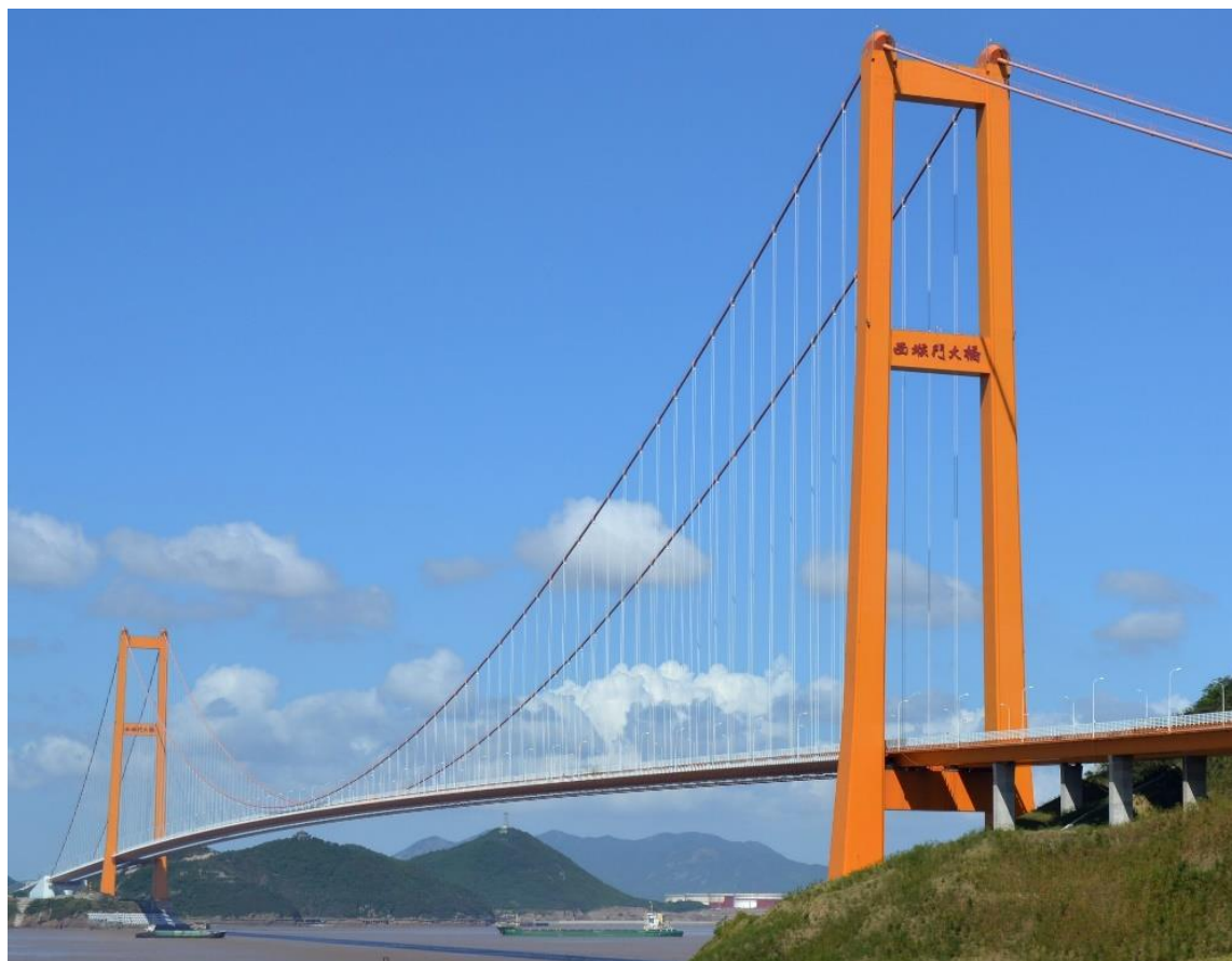
Obr.: Ocelový visutý most (Xihoumen Bridge v Číně - spojuje ostrovy Jintang a Cezi jižně od Šanghaje, otevřen 2009, rozpětí: 578+1650+475 [m], pylony: žel. bet., výšky 211 m, hlavní kabel \varnothing 855 mm)
