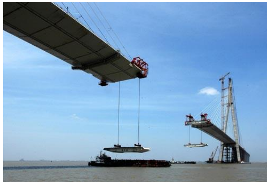
Obr.: Ocelový zavěšený most (Sutong Bridge přes Yangtze River v Číně – silniční most, rozpětí 1088 m (2x100+300+1088+300+2x100), ž.b. pylony tvaru obráceného Y, výška 304 m )
