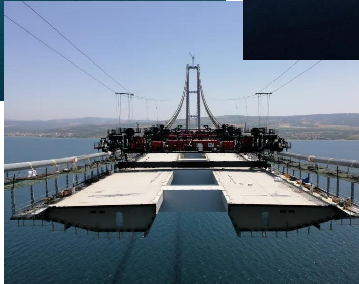
Obr.: 1915 Çanakkale Bridge – silniční most, překonává průliv Dardanely v Turecku, rozpětí mezi pylony: 2023 m, celková délka 4608 m, ocelové pylony výšky 318 m, vozovka 73 m nad hladinou
