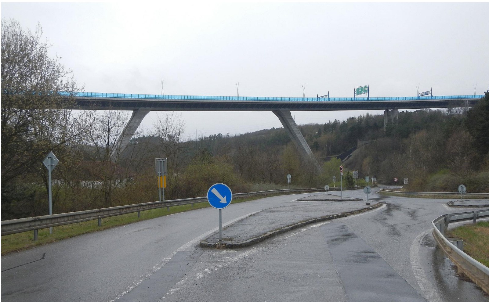
Obr.: Rámový most (Lochkovský most přes Lochkovské údolí v Praze – silniční most, sdružený rámový most – ocelová NK a ŽB spodní stavba)
