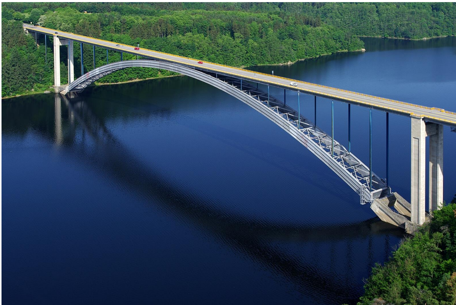
Obr.: Ocelový obloukový most s horní mostovkou (Žďákovský most – silniční most, dvoukloubový oblouk, rozpětí oblouku 330 m, výška nad hladinou 50 m )
