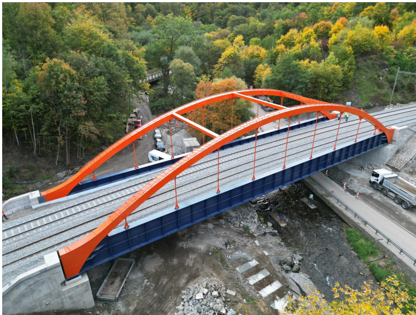
Obr.: Ocelový obloukový most s dolní mostovkou (most na trati Brno-Blansko – železniční most, rozpětí oblouku 58 m, tzv. Langerův trám)
