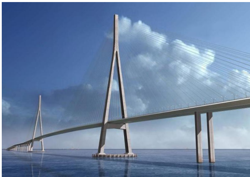
Obr.: Ocelový zavěšený most (Sutong Bridge přes Yangtze River v Číně – silniční most, rozpětí 1088 m (2x100+300+1088+300+2x100), ž.b. pylony tvaru obráceného Y, výška 304 m )
