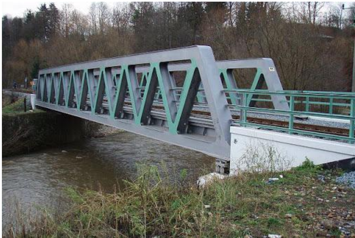
Obr.: Ocelový příhradový trémový most (železniční most přes Labe)
