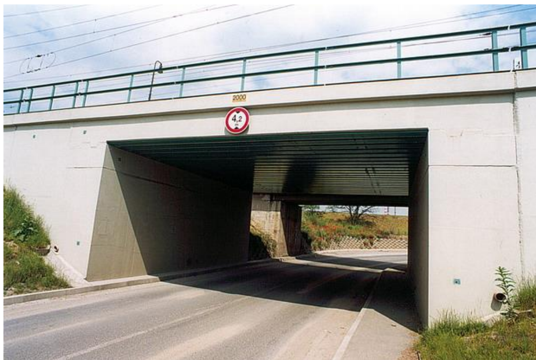
Obr.: Příklad betonového deskového mostu
