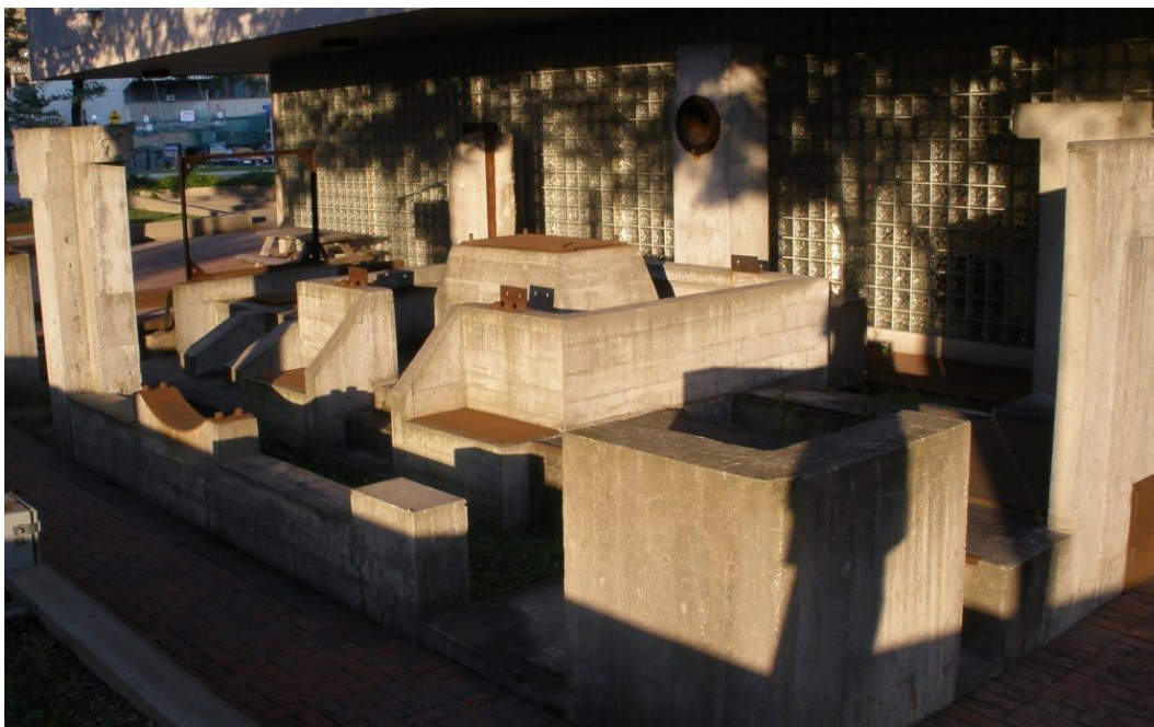
Fotografie č. 1. A & B associés. Transformer Site .
