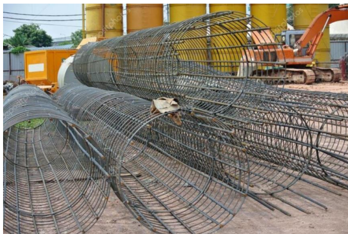
Výztužné armokoše vrтанých pilot
