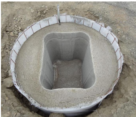
Kalich pro osazení prefa sloupu
