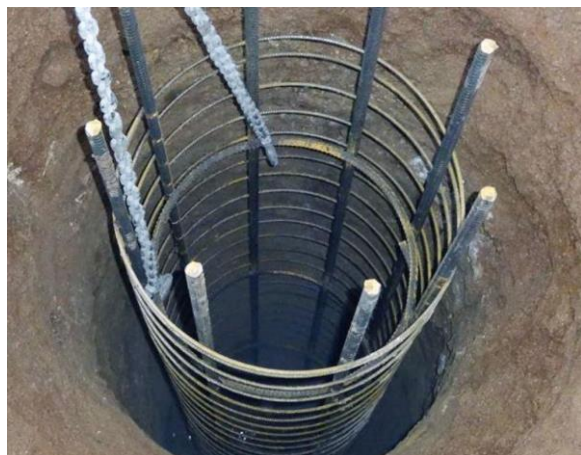
Výztužné armokoše vrтанých pilot
