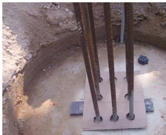
Pilota pod monolitický sloup šablona pro osazení výztuže
