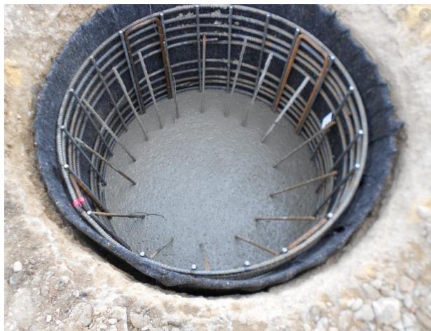
Bednění a výztuž hlavice pro prefa sloup
