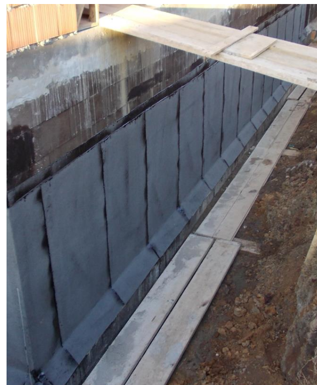
Hydroizolace živičnými pásy „černá vana“
