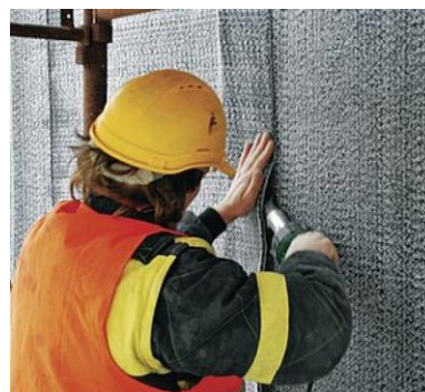
Bentonitové rohože Voltex „hnědá vana“
