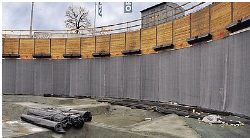
Bentonitové rohože Voltex „hnědá vana“
