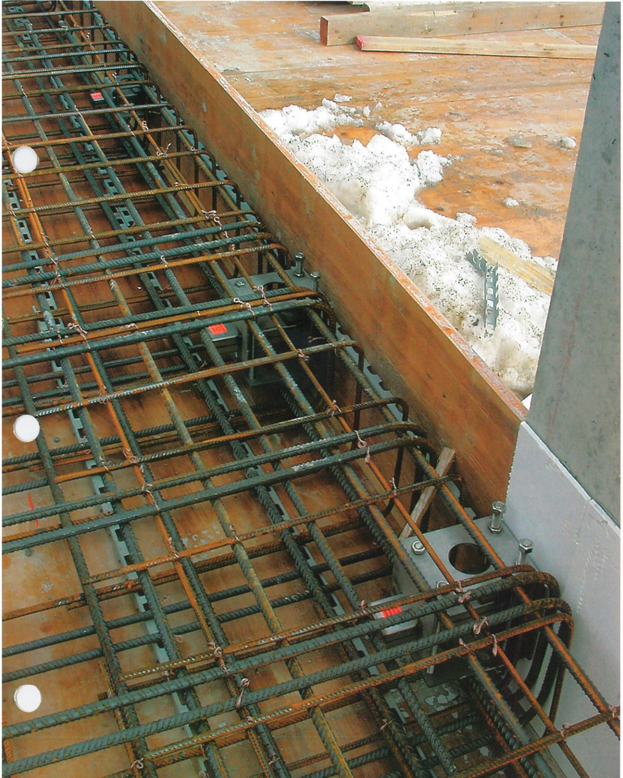
Pohled na osazené smykové trny v dilataci před betonáží desky
