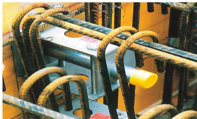
Dilatace pomocí smykových trnů – moderní varianta kluzného uložení na ozub
