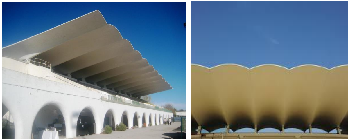
Hippodrome La Zarzuela, Madrid - Eduardo Torroja, 1935 konzolová válcová skořepina zastřešení fotbalového stadionu – vyložení konzoly 12,8 m
