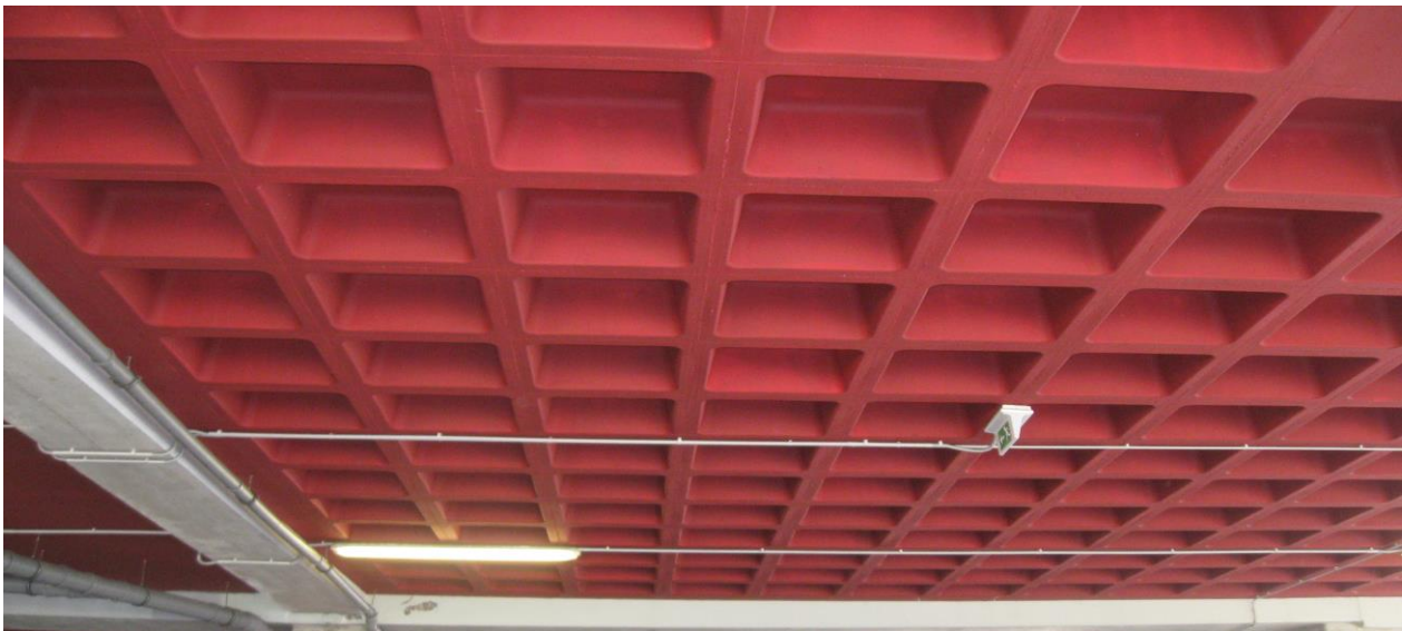
Monolitická část stropu parkovacího domu obchodního centra Nisa Liberec
