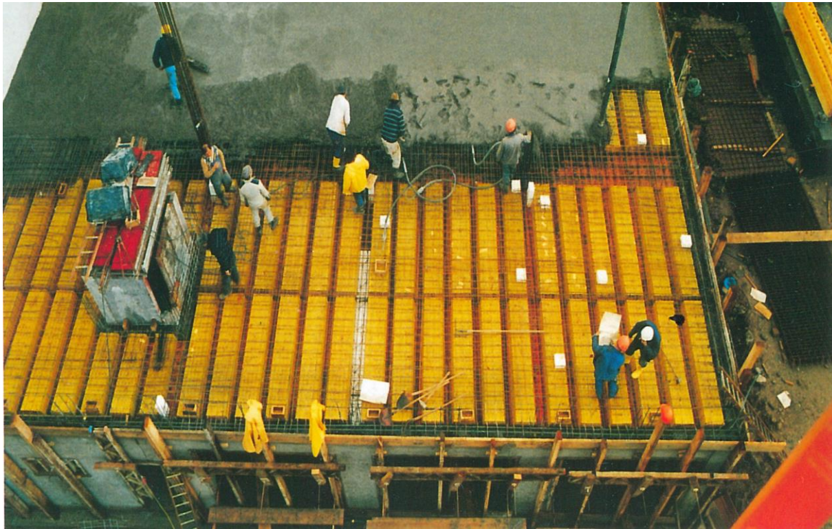
Bednění Pecafil pro žebrový strop
