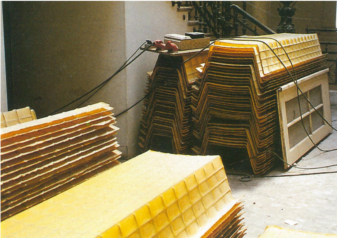
Bednění připravené pro použití v dalším podlaží
