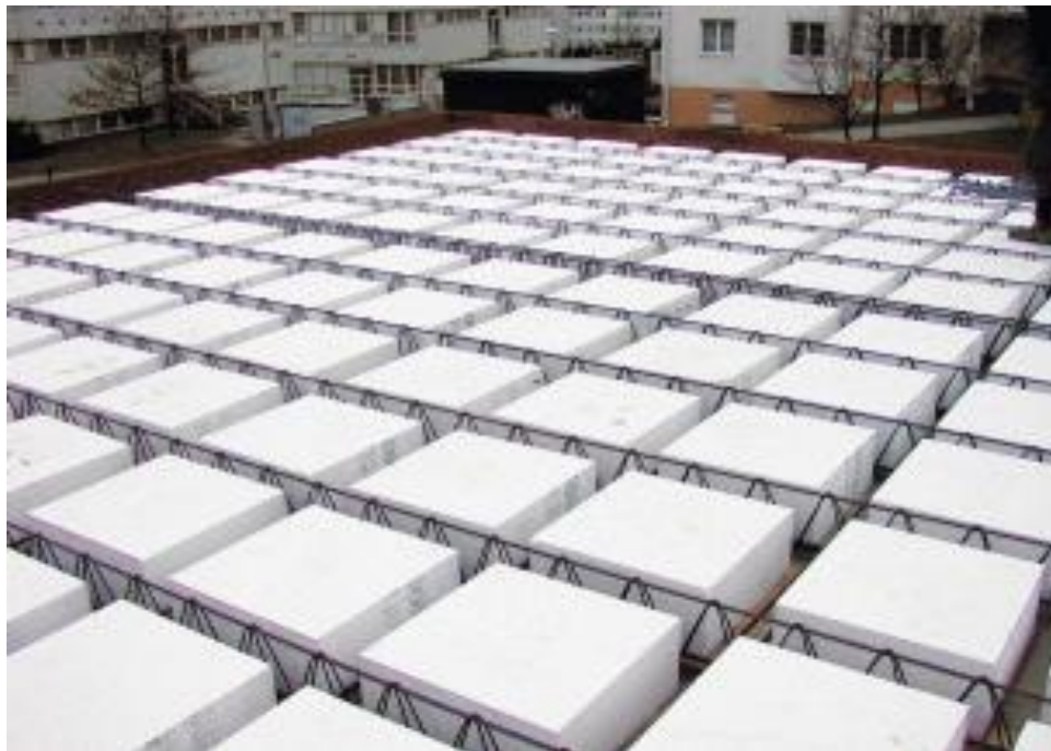
Ztracené bednění z polystyrénových kvádrů – výsledkem je rovný pohled
