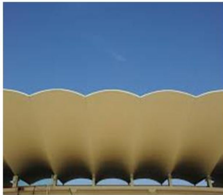
Hippodrome la Zarzuela, Madrid – Eduardo Torroja, 1935 Konzolová válcová skořepina – vyložení konzoly 12,8 m
