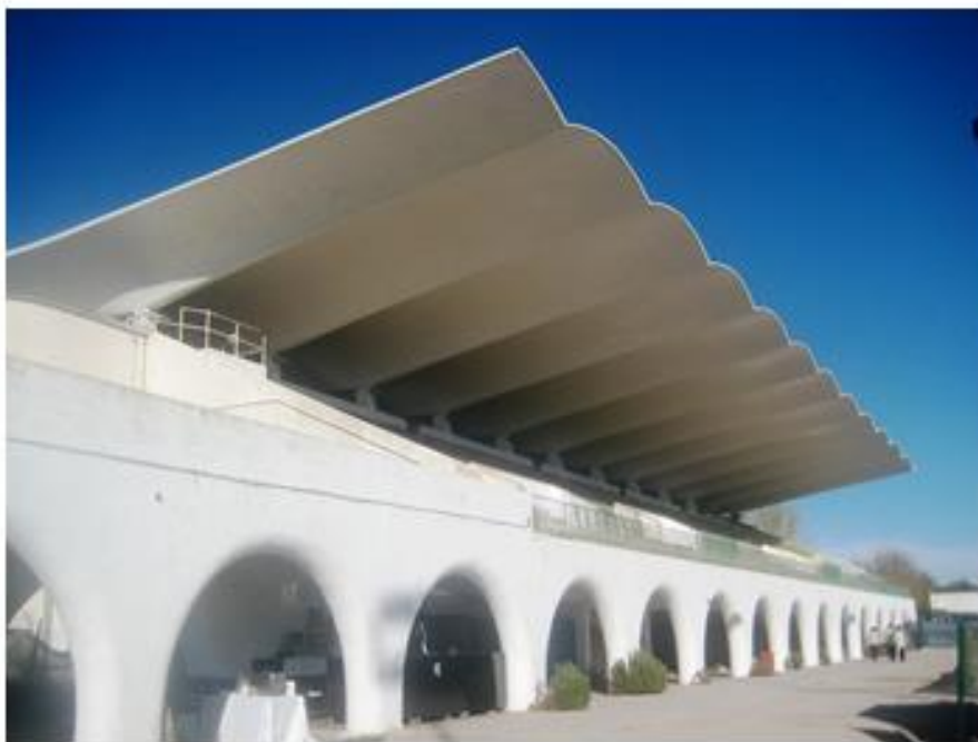
Hippodrome la Zarzuela, Madrid – Eduardo Torroja, 1935 Konzolová válcová skořepina – vyložení konzoly 12,8 m
