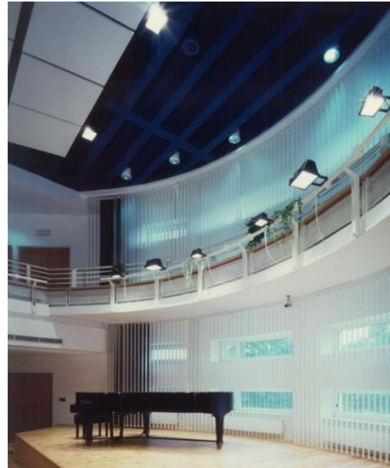
Žebrový strop sálu ZUŠ Liberec
