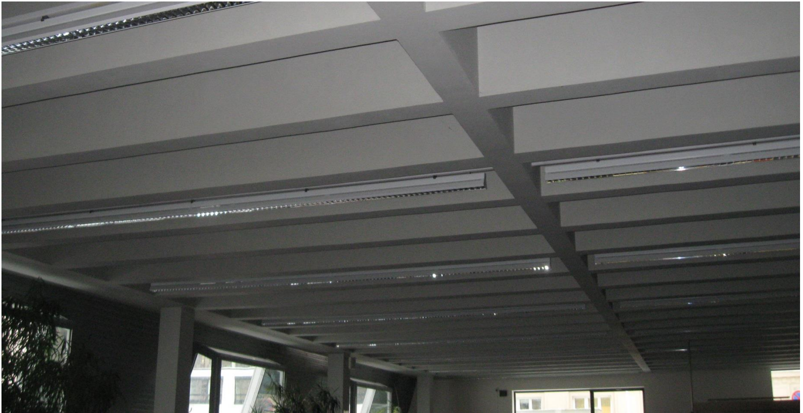
Strop nad menzou na TUL – pohled na příčné žebro
