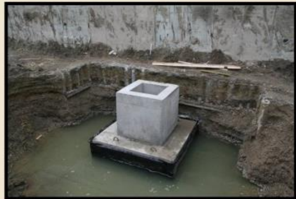
Patky s kalichem pro kotvení sloupů
