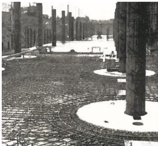
Výztuž stropní desky kolem prefa hlavice
