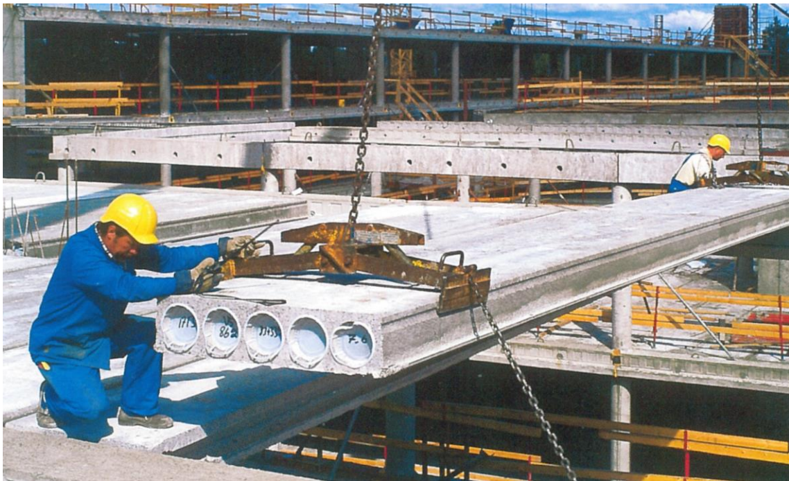
Montáž stropního panelu Spiroll
