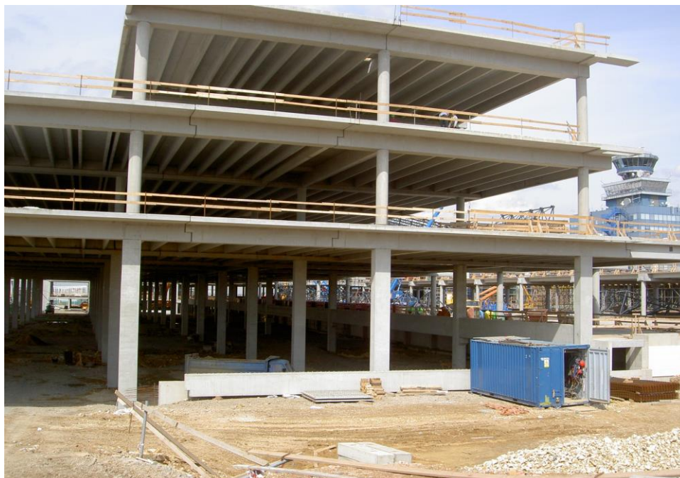
Stropy na rozpětí 15 m z panelů TT
