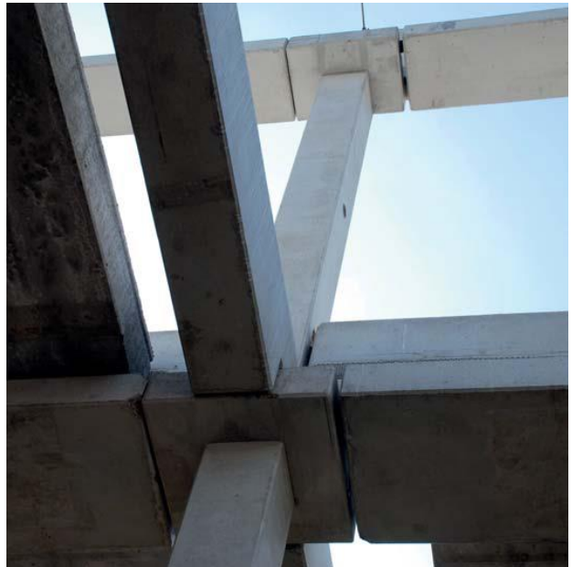
Skelet s průběžnými sloupy s hlavicemi
