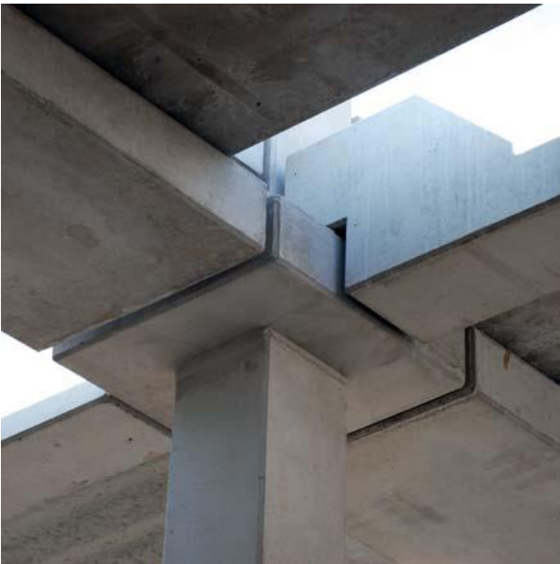
Skelet s průběžnými sloupy s hlavicemi
