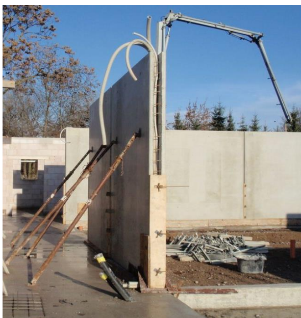
Filigránové prvky lze používat i pro prefamolitické stěny
