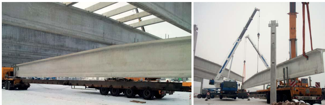
Detaily osazení železobetonových vazníků
