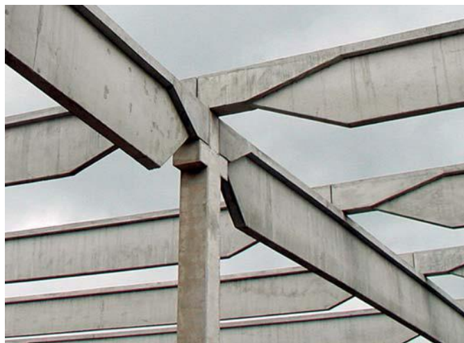
Plnostěnné železobetonové vazníky průřezu T
