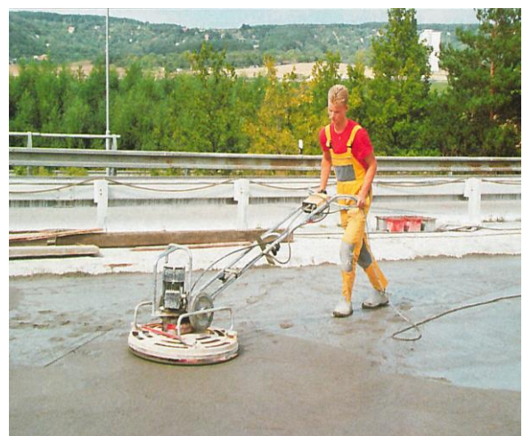
Hlazení desky vrtulovými hladičkami
