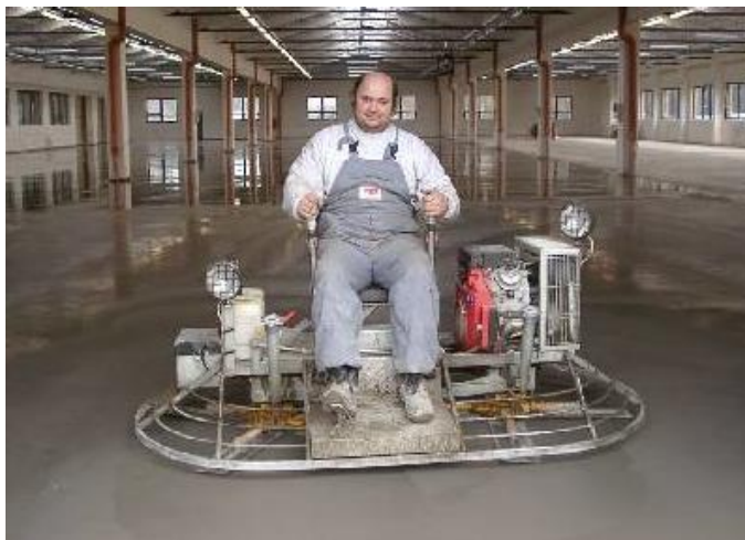
Hlazení desky vrtulovými hladičkami
