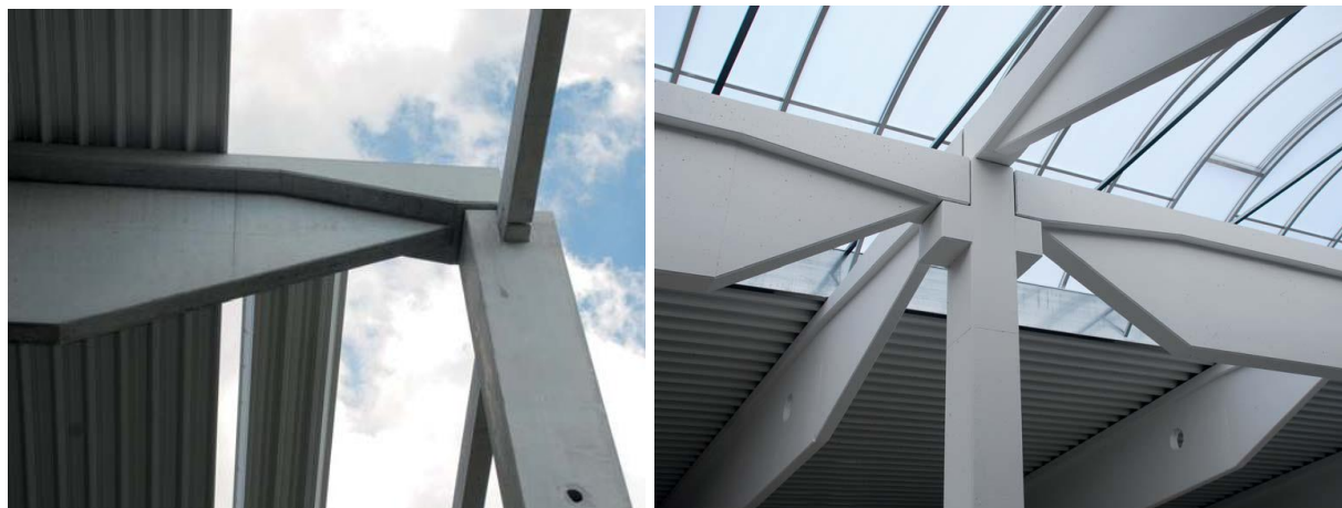
Detaily osazení železobetonových vazníků
