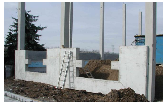
Úprava prahu v místě nakládacího můstku haly
