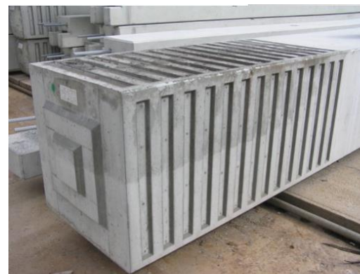
Úprava sloupu v patě
