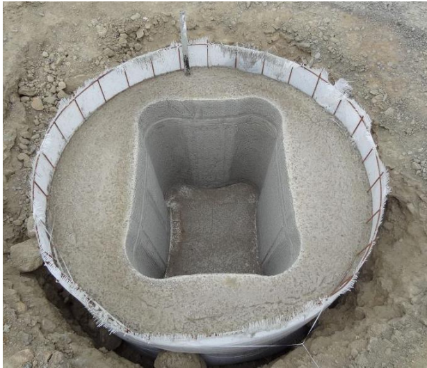
Kalich pro osazení prefa sloupu
