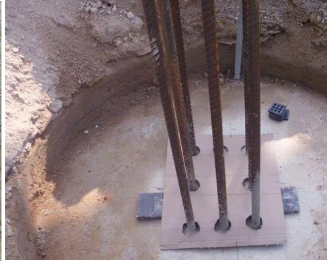
Pilota pod monolitický sloup
