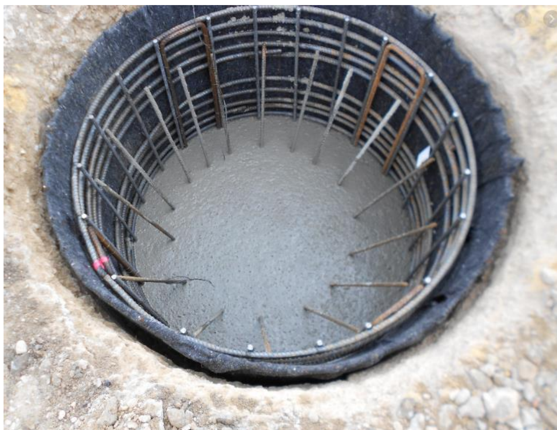
Bednění a výztuž hlavice pro prefa sloup
