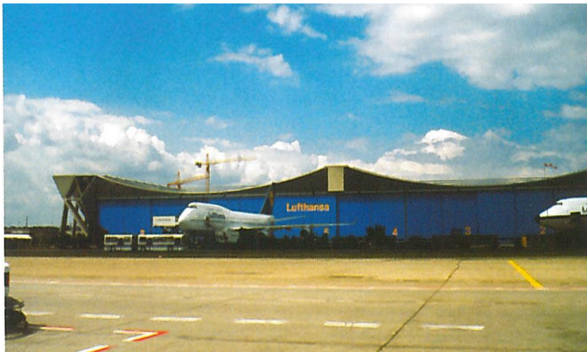
Hangár na letišti ve Frankfurtu (1970)
