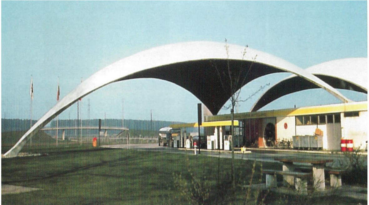
Čerpací stanice Deitingen Süd na dálnici Bern – Zürich – 2 x trojúhelníkový půdorys 31,6 x 26 m, tloušťka 90 mm
