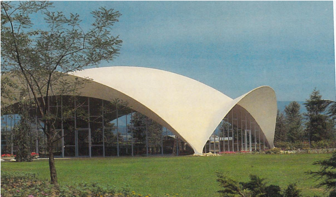
Odpovídající skutečná konstrukce – zahradní centrum Florétites Clause SA, Paříž diagonální rozpětí 41 m, tloušťka skořepiny 80 mm.
