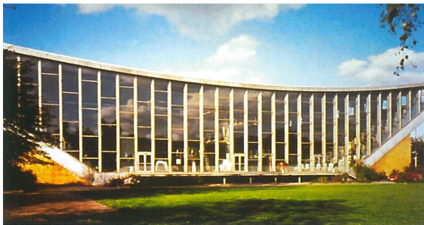
Plavecký stadion ve Wuppertalu – Fritz Leonhardt, 1965 předpjatá visutá skořepina s rozpětím 65 m, tloušťka 57 mm
