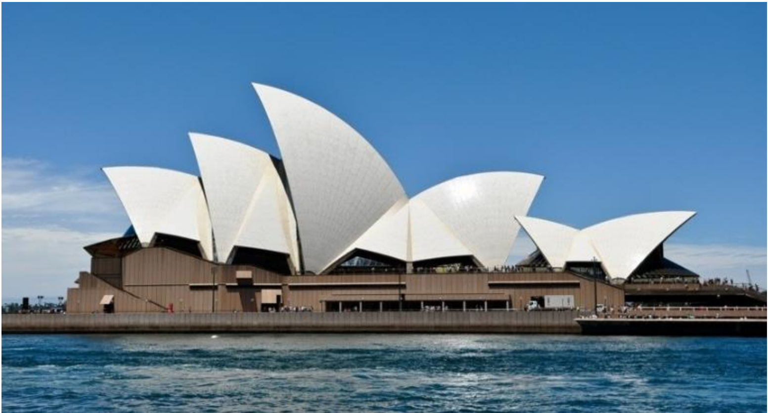
Opera v Sydney – 1973 – skořepinové dílce z ferrocementu tloušťky 30 mm
