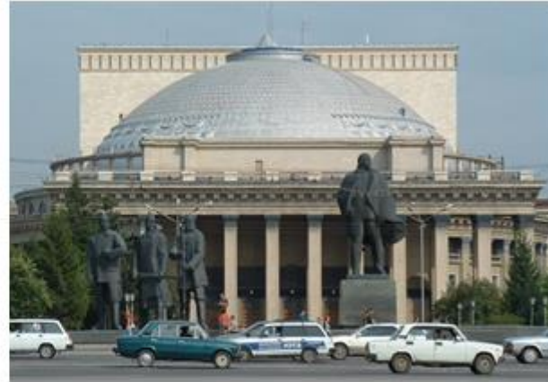
Divadlo Novosibirsk – 1944 - rozpětí 55,50 m (kulová bání o poloměru 30 m) tloušťka 80 mm
