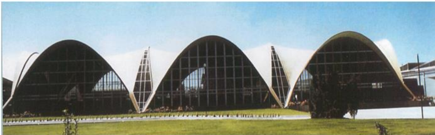
Továrna Bacardi, Cautitlán Mexiko – Félix Candela 1960 Hyperbolické paraboloidy, tloušťka převážně 40 mm
