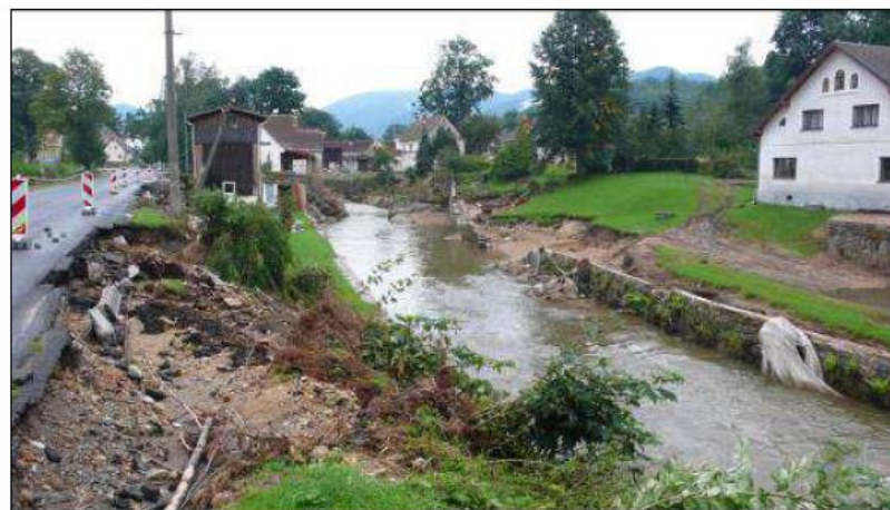
Obr.31 Pohled na koryto Smědě pod tímž jezem, 2010. K nepříznivým účinkům jezových staveb je v řadě případů potřeba vedle vytváření migračních překážek, ochuzování koryta o přirozenou spádnost a rizikového povodňového vzdouvání v naději přičíst koncentrované destruktivní působení povodňového proudu v úseku bezprostředně pod jezem. K tomu dochází v důsledku lokálního zrychlení povodňového proudu, přepadajícího přes jez. (Podobně působí čemé mosty, lávky a propusty.)
