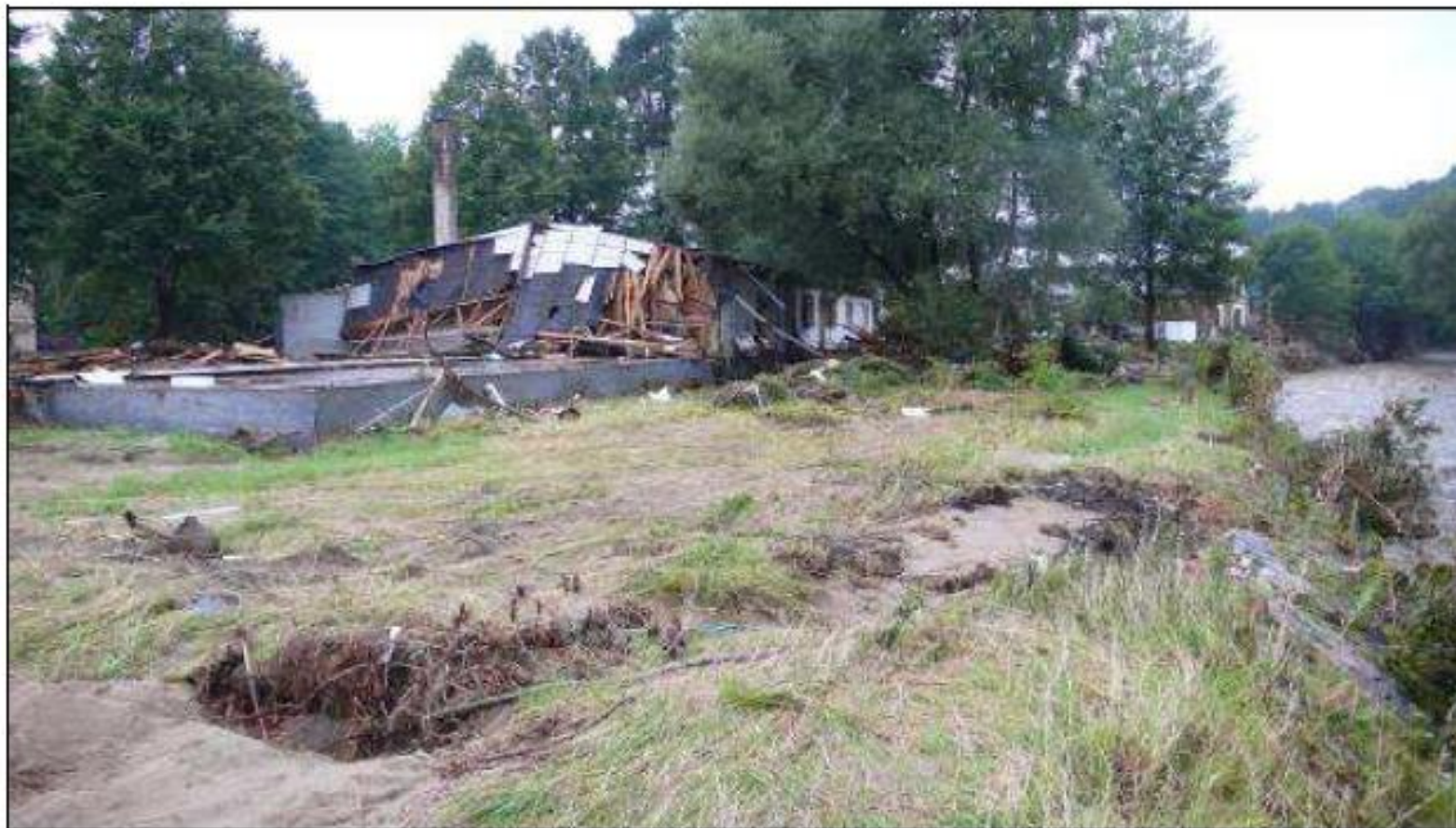
Obr.12 K degradaci nivních území náleží také nevhodné umístování staveb, které za povodní jednak zvyšují vzduť, jednak jsou samy ohrožovány a poškozovány. Dřevěné a podobné stavby se navíc mohou za povodní stávat zdrojem materiálu, který dál po toku vytváří bariéry. Ubytovna na dolním okraji Frýdlantu, rozvalená rozvodněnou Smědou v srpnu 2010.
