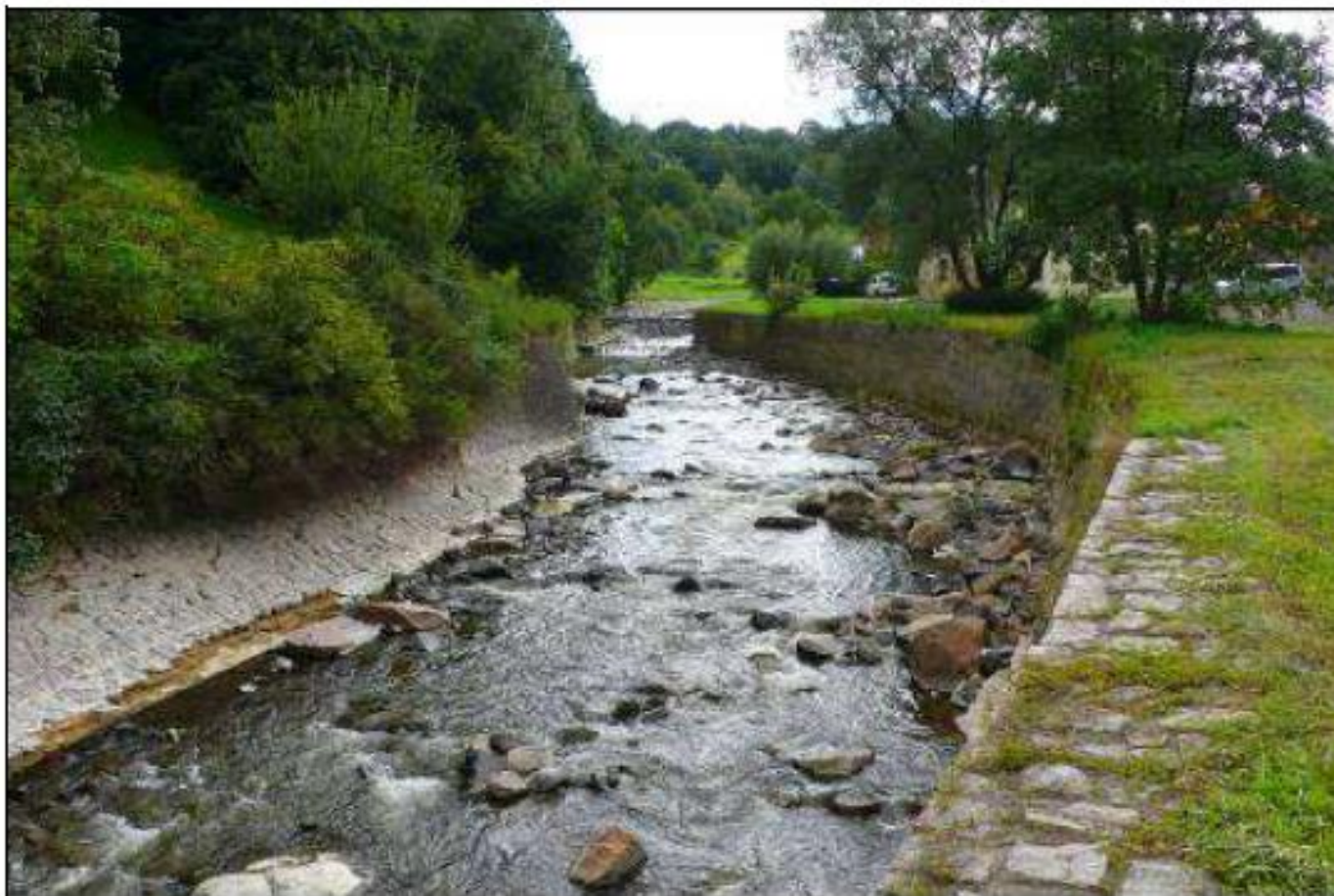
Obr.14 Jiný úsek Jílovského potoka na Děčínsku. Po povodni roku 2010 je vystaveno dno z hrubého kamenitého materiálu, což naznačuje možný směr zlepšení stavu koryta – alespoň dno by mohlo být tvarově a hydraulicky členité a migračně prostupné. Popovodňová kamenitá struktura dna naznačuje možnosti revitalizačních řešení i v poměrně sklonitých úsecích toků.
