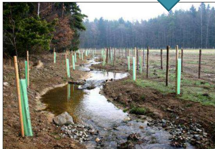
Obr.4 Pekelský potok u Zdislavic po dokončení stavební části revitalizace v roce 2007. Bylo vytvořeno nové, přírodě blízké koryto. Je členité, mělké a má malou průtočnou kapacitu, což podporuje rozlévání větších průtoků do okolních ploch. Stavba byla provedena s podporou Programu revitalizace říčních systémů Ministerstva životního prostředí.
