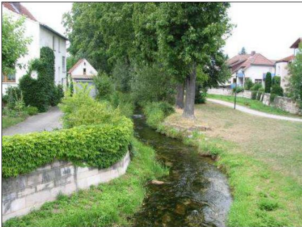
Obr.15 Potok Lauterbach v Bad Staffelstein v Bavorsku prodělal protipovodňovou a revitalizační úpravu v roce 1998. Do jeho dostatečně kapacitního povodňového průtočného koridoru, který proti okolní zástavbě vymezují architektonicky řešené zdi, se dnes vejde přírodě blízká kyneta pro běžné průtoky, parková úprava se vzrostlými stromy a vycházková cesta.
