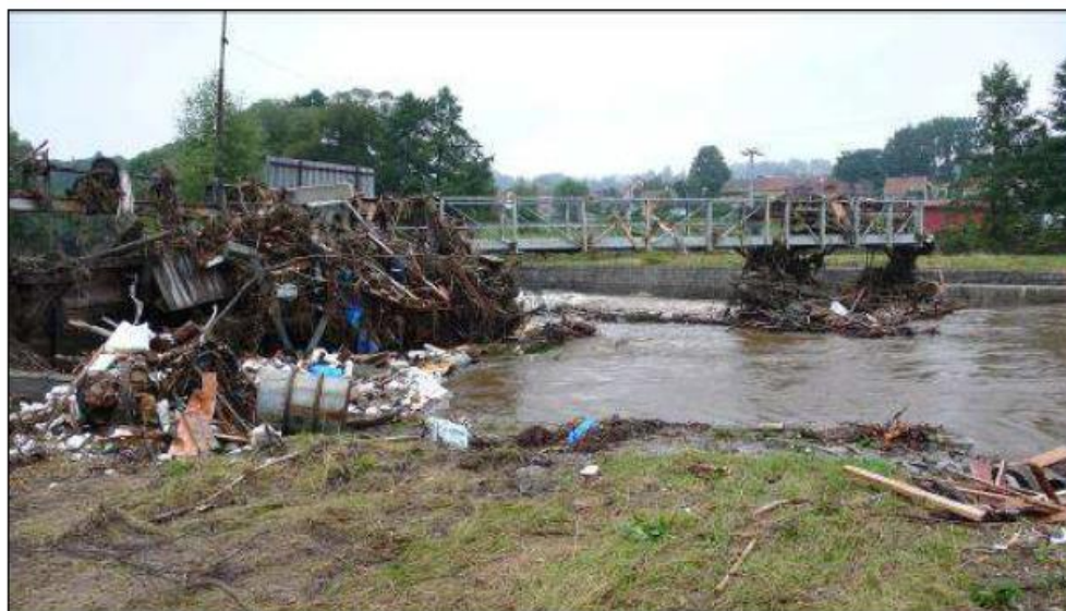
Obr.29 Tentýž jez v pohledu po vodě, týden po povodni v srpnu 2010. Většina zachyceného splávi již byla tou dobou odstraněna.
