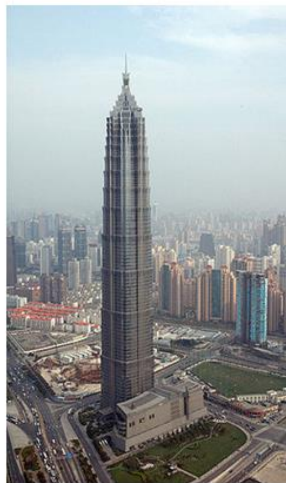
Jin Mao Tower Šanghaj 1999, 421 m Core-Outrigger Mega Frame jedna z prvních realizací tohoto systému
