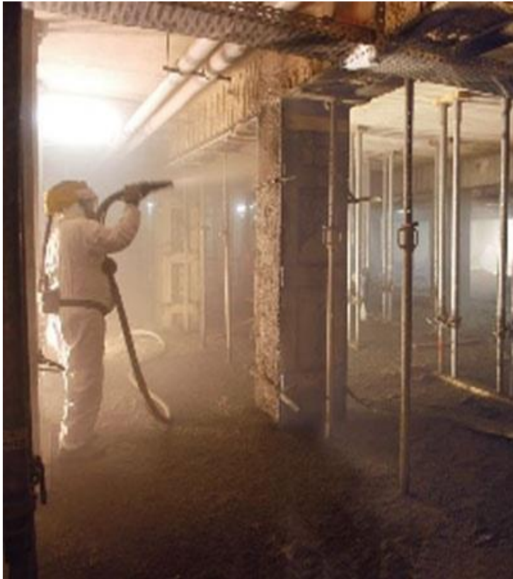
Torkretování (stříkání) betonu)
