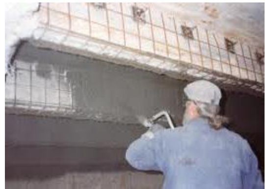
Torkretování (stříkání) betonu)
