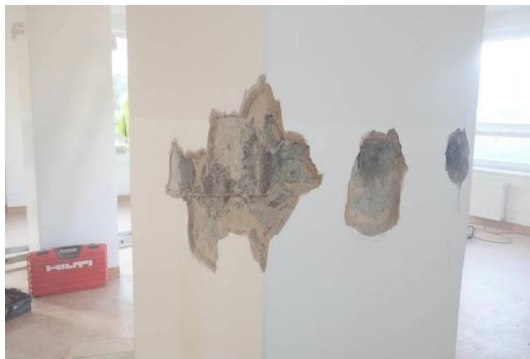
Sonda k výztuži sloupu
