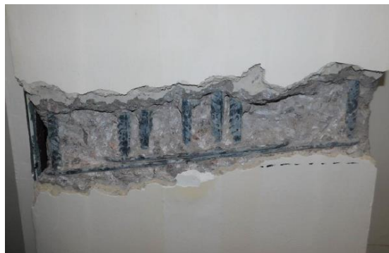
Sonda ke spodní výztuži průvlaku
