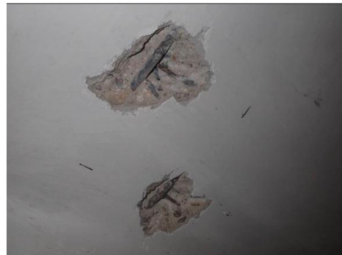
Sonda ke spodní výztuži stropní desky
