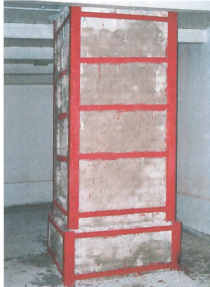
Obrázek 4.92 Ocelová bandáž sloupu
