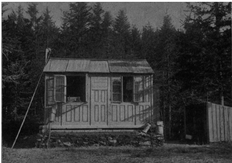
Obrázek 7: „Létací“ zoologická stanice na břehu Černého jezera, kolem r. 1895. Tato malá mobilní laboratoř pro hydrobiologické výzkumy měla skládací konstrukci a na místo ji přepravoval koňský povoz. Převzato z práce Friče a Vávry (1898).
