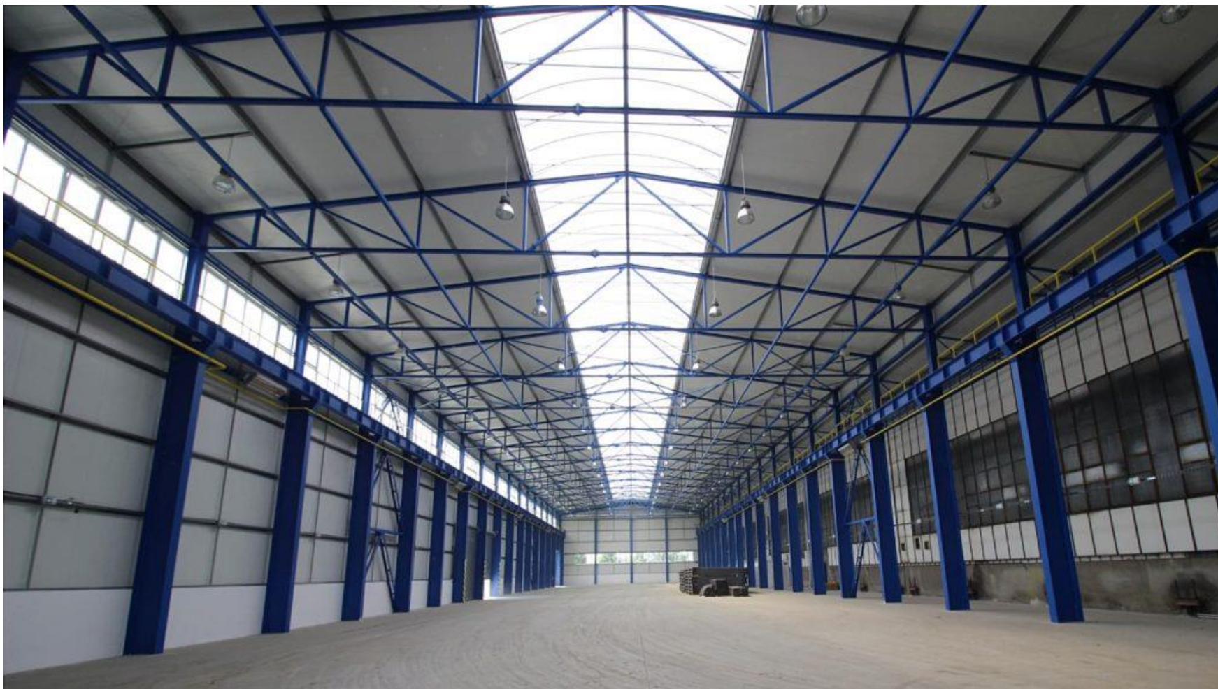
Ocelová jednolodní hala s příhradovými vazníky
