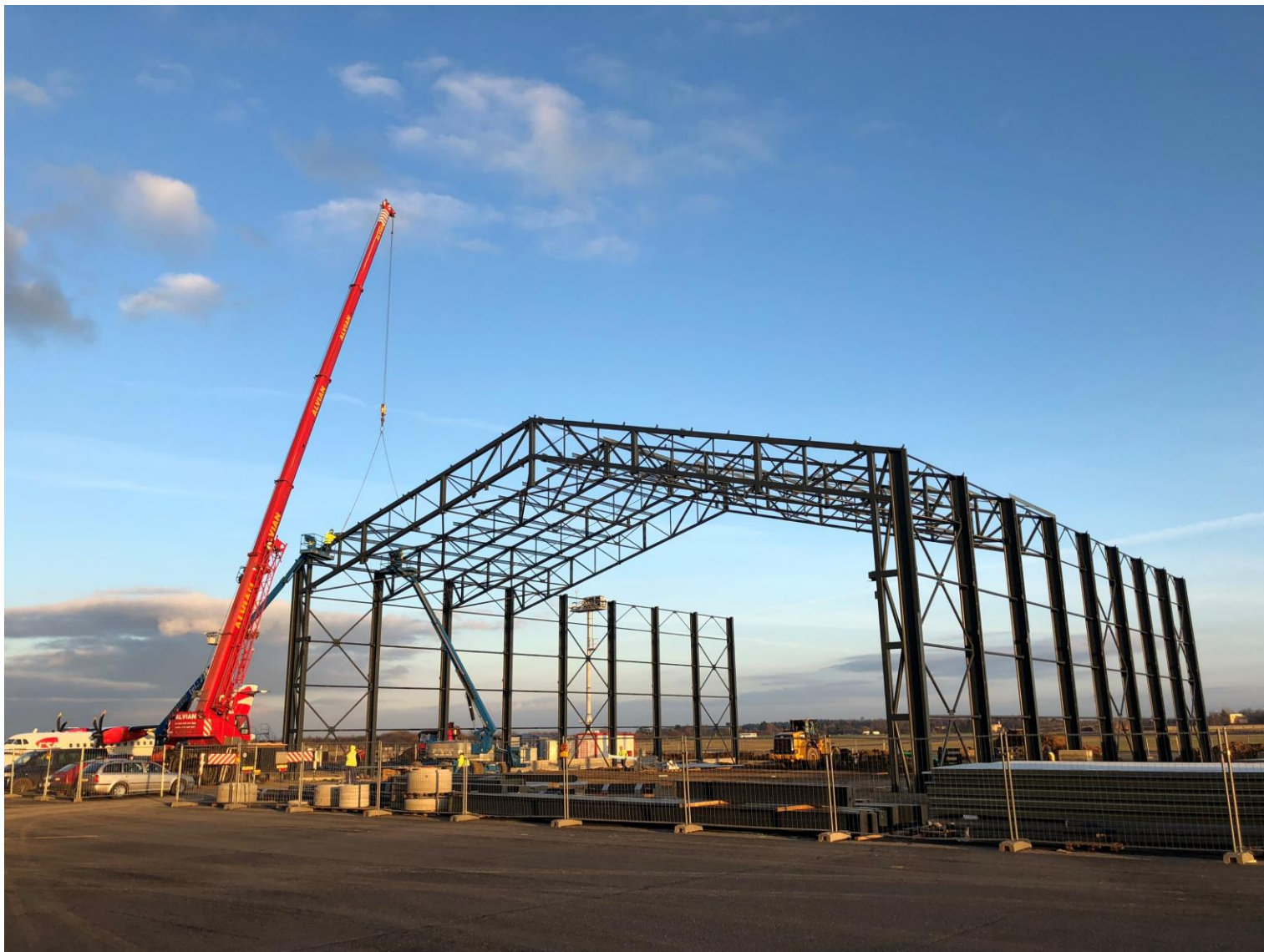
Ocelová jednolodní hala s příhradovými vazníky
