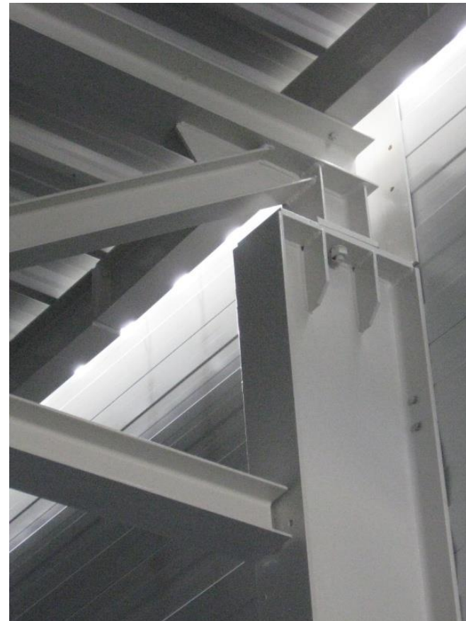
uložení vazníku na horní pás
