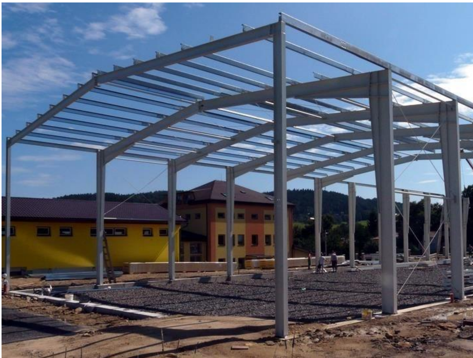
Ocelová jednodílná rámová hala (trojkloubový rám)
