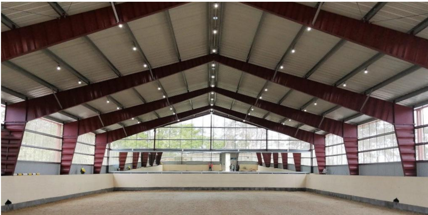
Ocelová jednolodní rámová hala (trojkloubový rám)
