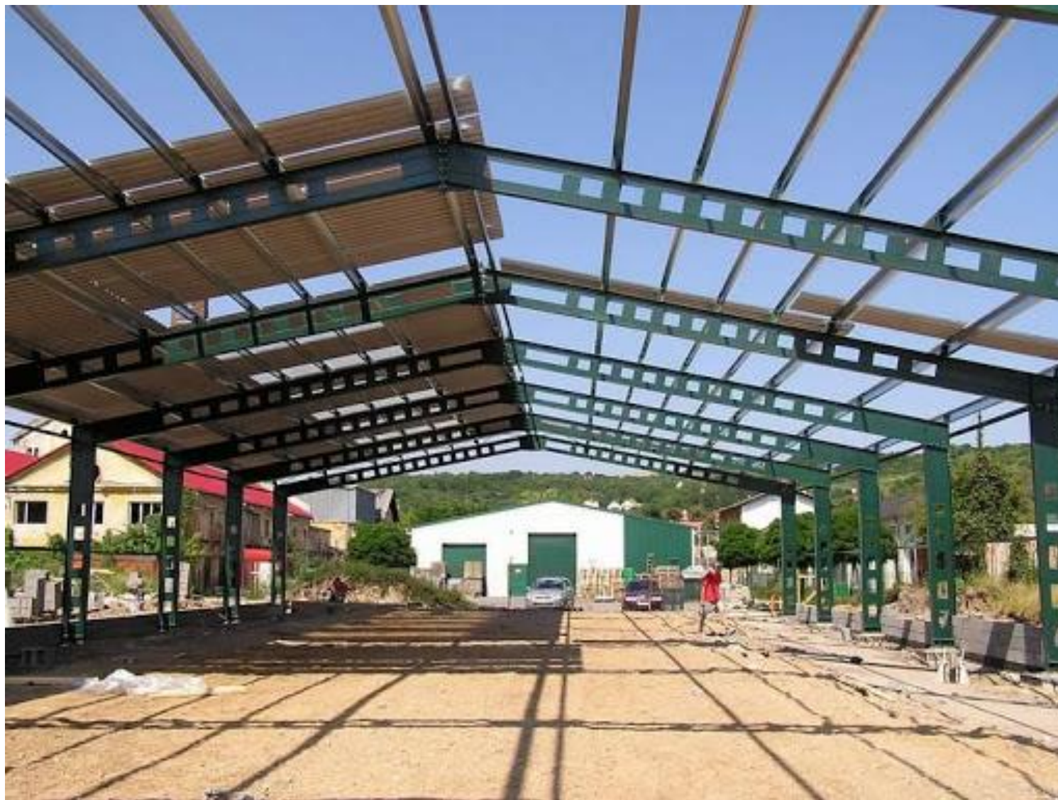
Ocelová jednolodní rámová hala (trojkloubový rám)
