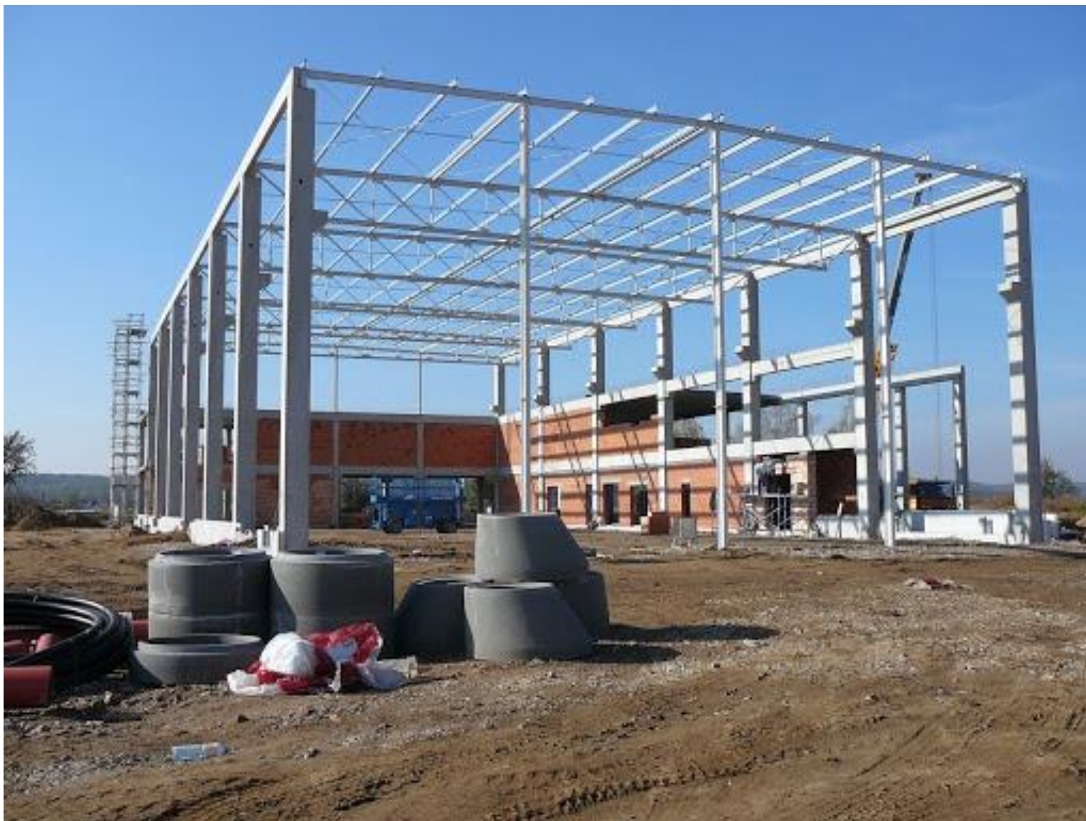
Ocelová jednolodní hala s příhradovými vazníky
