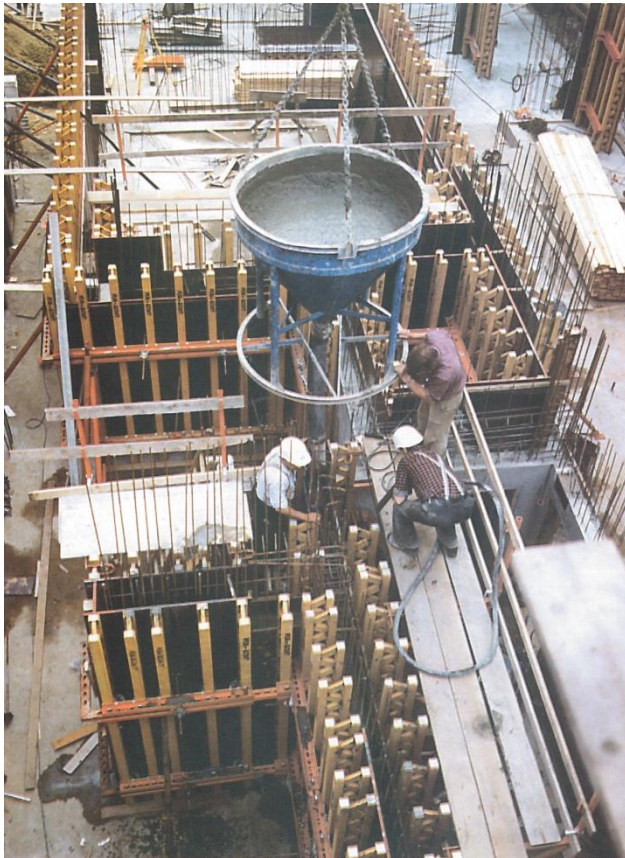
běžná betonáž stěny shora
