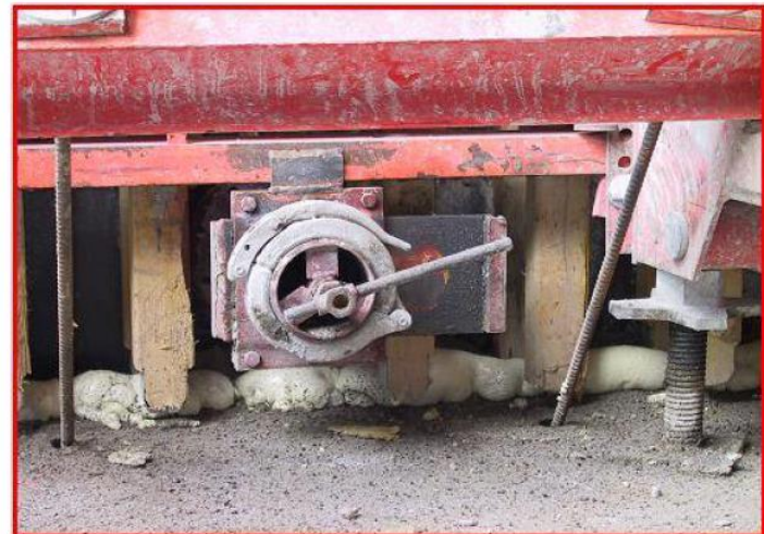
plnění bednění speciálním ventilem zdola
