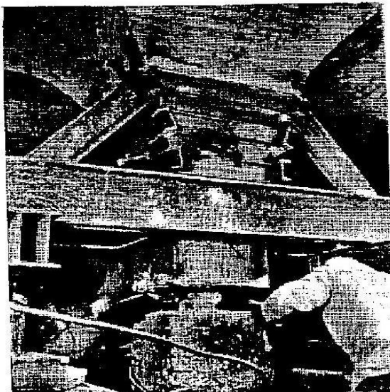
Obr. 4.73 b) Postup výměny porušeného zděného pilíře
